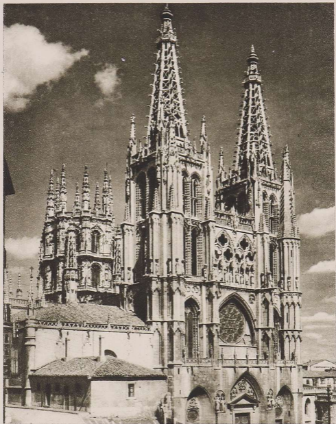
BURGOS. CATEDRAL. FACHADA PRINCIPAL
